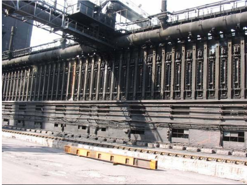
3.1 ábra: Fénykép egy kokszolóblokkról (láthatóak a kamrák, a fáklyák, a gázgyűjtőcső valamint a széntorony)
